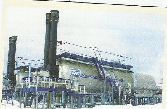
Аппарат Heater-Treater производства Sivalls
